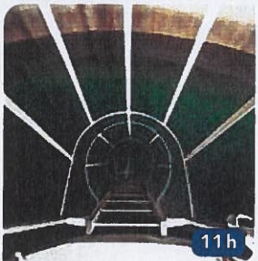
CHÂTEAU D'EAU Bedenac
