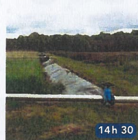
STATION D'ÉPURATION des matières de vidange - Bois
