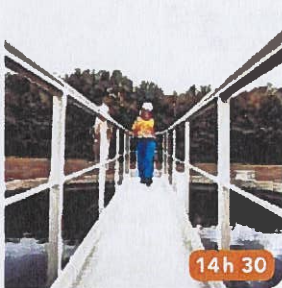
STATION D'ÉPURATION à boues activées - Gémozac
