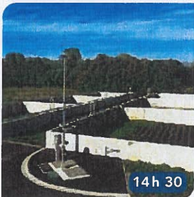
STATION D'ÉPURATION à boues activées - Benon
