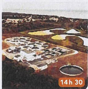
STATION D'ÉPURATION à boues activées - La Cotinière
